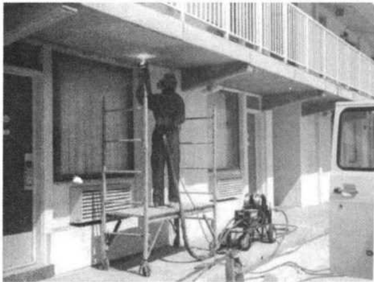
شکل ۹-۴ اعمال اسپری قوس آند گالوانیک
